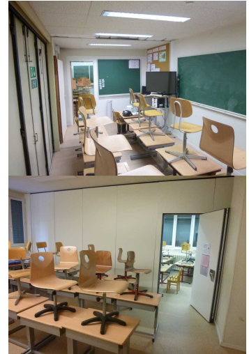
改修工事をした第4、8教室
